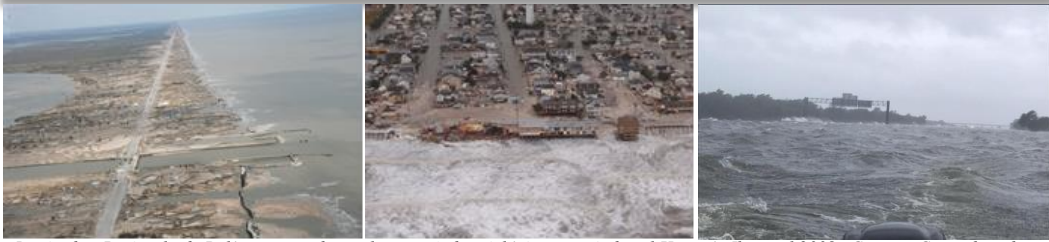
Izquierda: Península de Bolívar arrasado por las marejadas ciclónicas asociadas al Huracán Ike en el 2008. Centro: Casas dañadas y destruidas a lo largo de las costas de New Jersey tras el paso de Sandy en el 2012. Cortesía de la Guardia Costero del los Estados Unidos. Derecho: Olas en la carretera I-10 a lo largo de la línea del condado de Jefferson/Chambers en el sureste de Texas durante la tormenta tropical Harvey en 2017.
