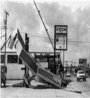
Estación de gasolina impactada por el huracán en Falfurrias.
